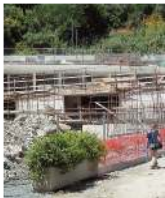
Il cantiere dei box di Albissola
