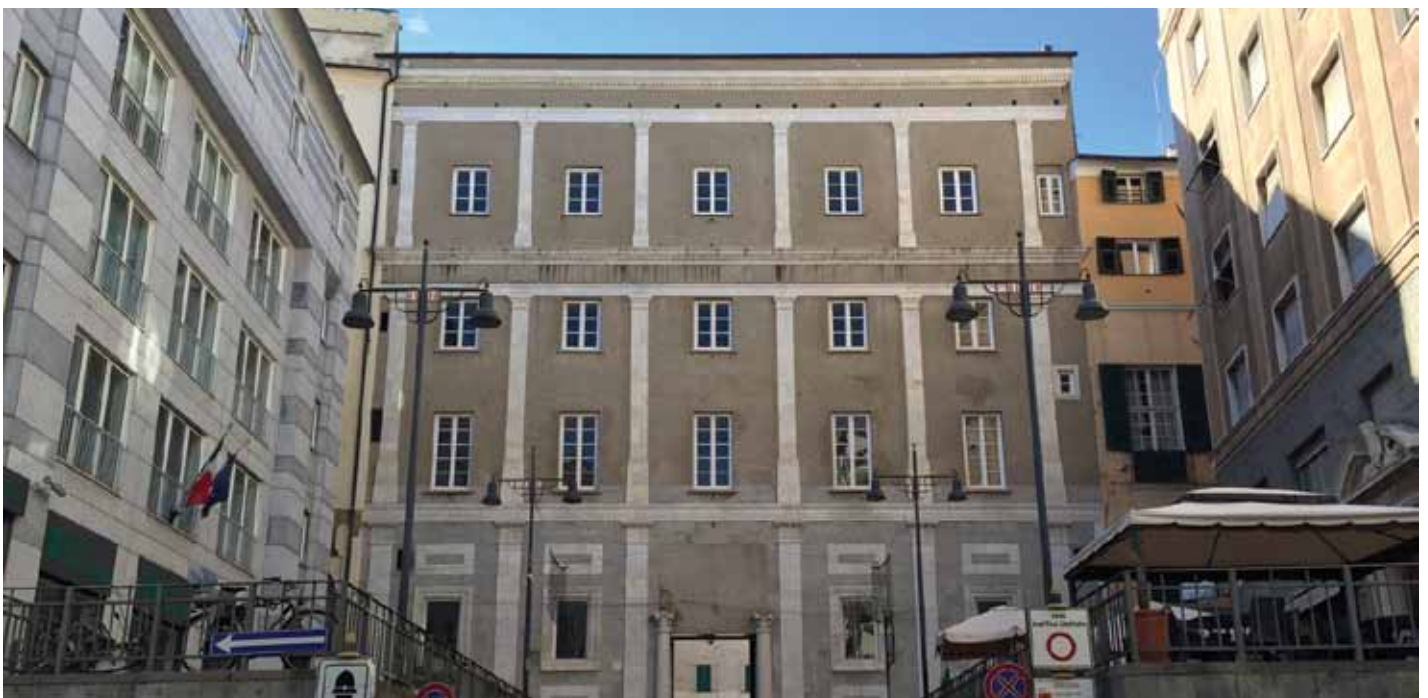
La facciata di Palazzo della Rovere su via Pia. Fonte: https://campionaridiparoleumori.wordpress.com/2015/09/12/palazzo-santa-chiara-come-facevamo-prima/
